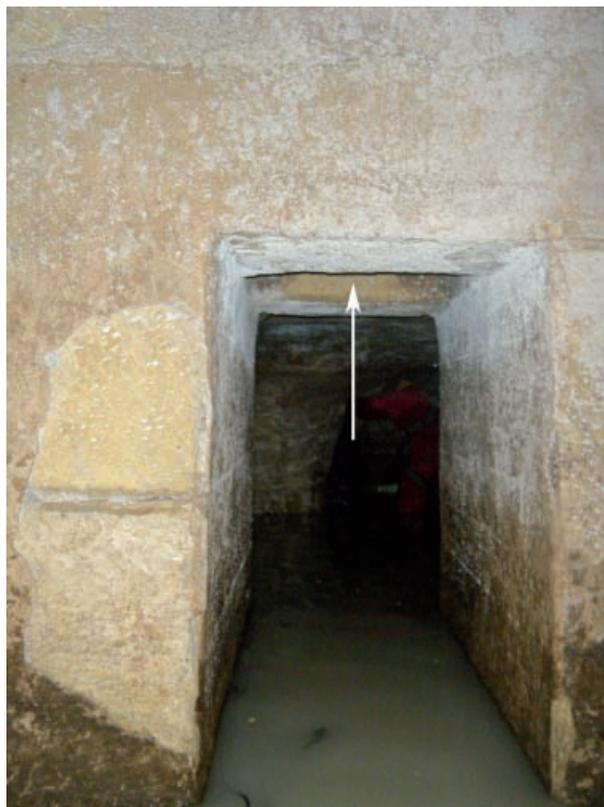
Fig. 8 – Vista degli ambienti 12 (a sinistra) e 15 (a destra); in primo piano sono ben visibili ampie porzioni di roccia, là dove è caduto l'intonaco.
